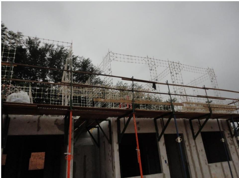
**Figura 11 – Telas de armadura em processo de montagem**
