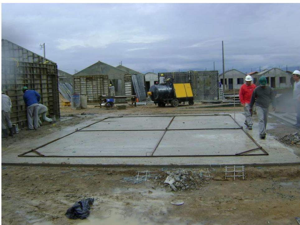
**Figura 7 – Quadro metálico para a marcação das paredes posicionado sobre o radier**
