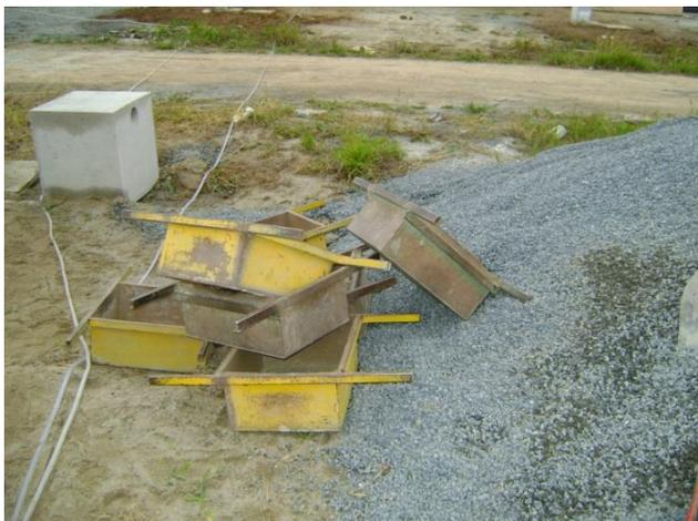
**Figura 14 – Padiolas para o proporcionamento dos agregados**
