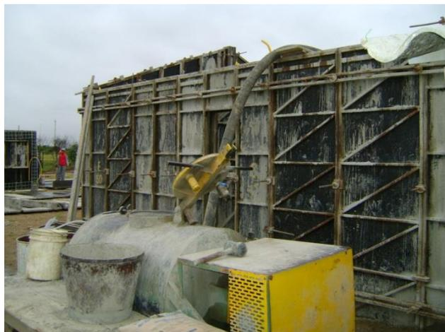
**Figura 15 – Equipamento para mistura e lançamento do concreto**
