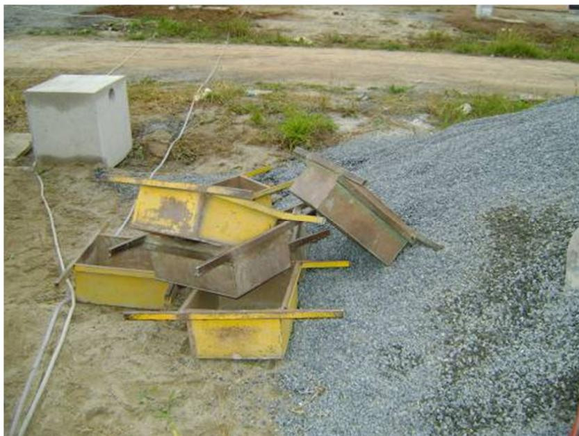
**Figura 10 – Padiolas para o proporcionamento do concreto**
