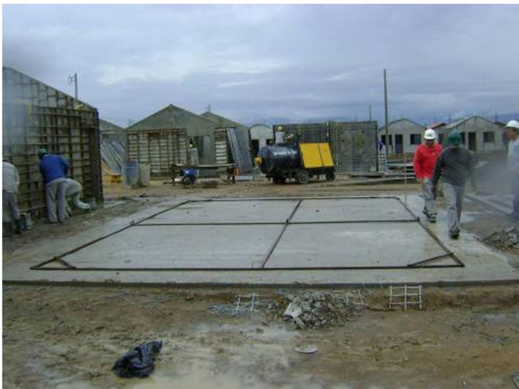
Figura 4 – Quadro metálico para a marcação das paredes posicionado sobre o radier
