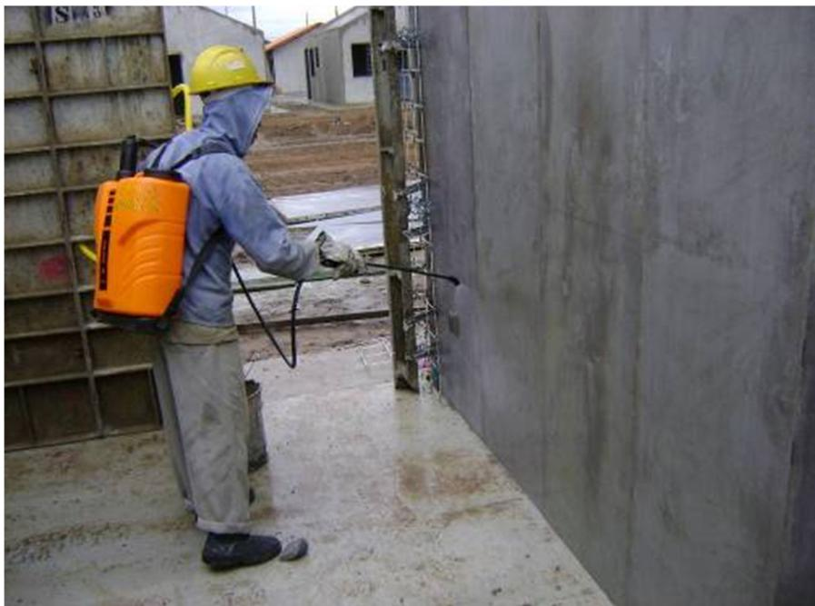
**Figura 6 – Aplicação de desmoldante no painel de fôrma**
