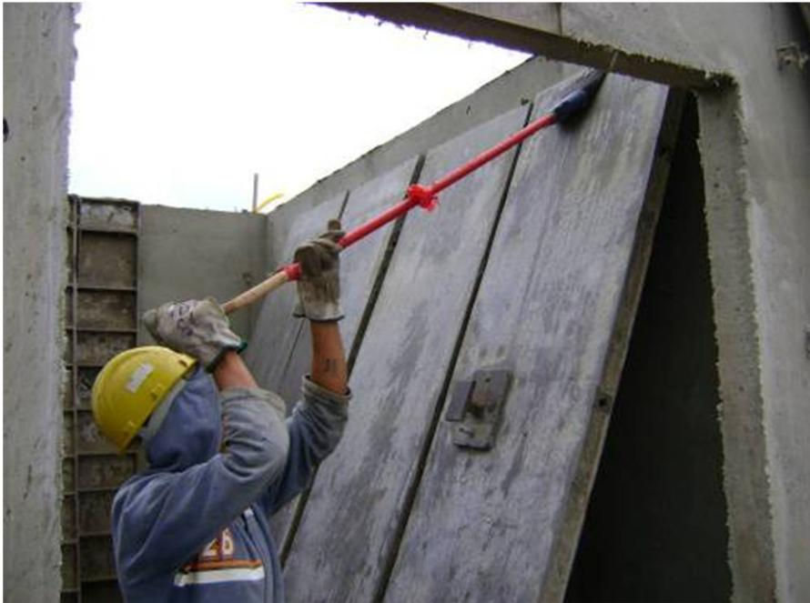
**Figura 5 – Limpeza dos painéis de fôrma**
