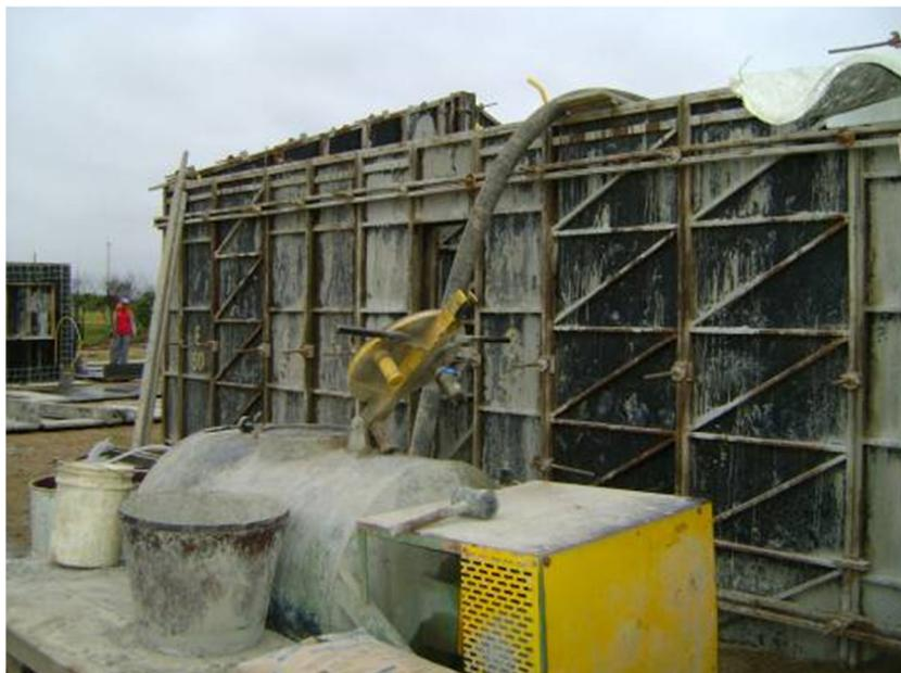
**Figura 11 – Equipamento para mistura e lançamento do concreto**
