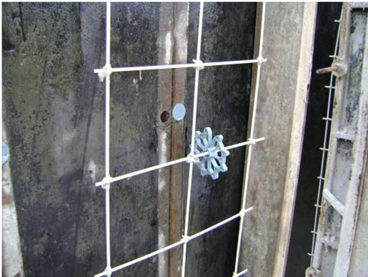
**Figura 8 – Espaçador plástico empregado na armadura**
