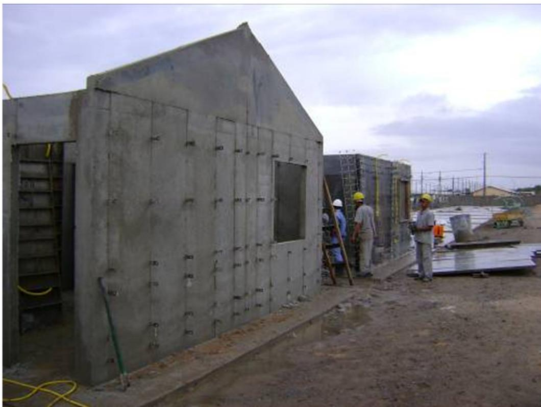
Figura 1 – Vista geral da desenforma e da montagem das fôrmas das paredes
