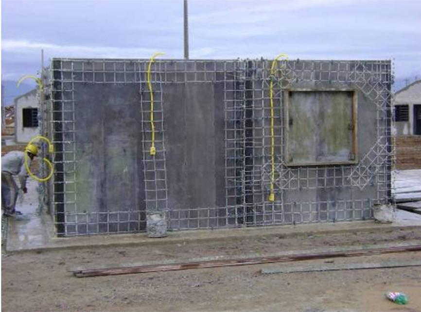
**Figura 7 – Montagem da armadura, eletrodutos e negativo de janela (obs.: ainda falta a colocação da tela no lado direito da janela)**
