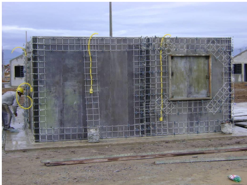
Figura 10 – Montagem da armadura, eletrodutos e negativo de janela (obs.: ainda falta a colocação da tela no lado direito da janela)
