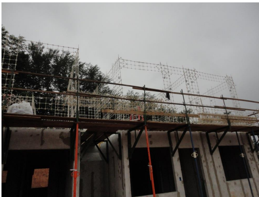
Figura 11 – Telas de armadura em processo de montagem
